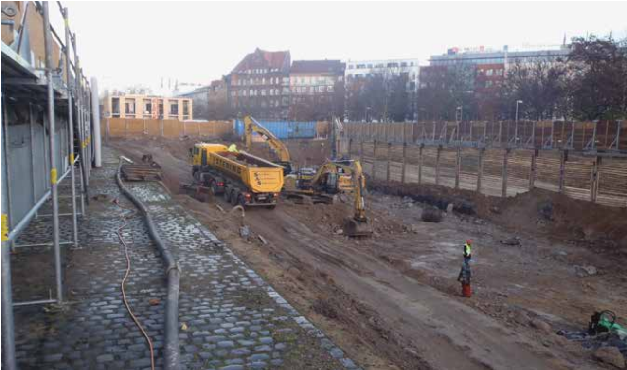
Herrichtung des Baufeldes
