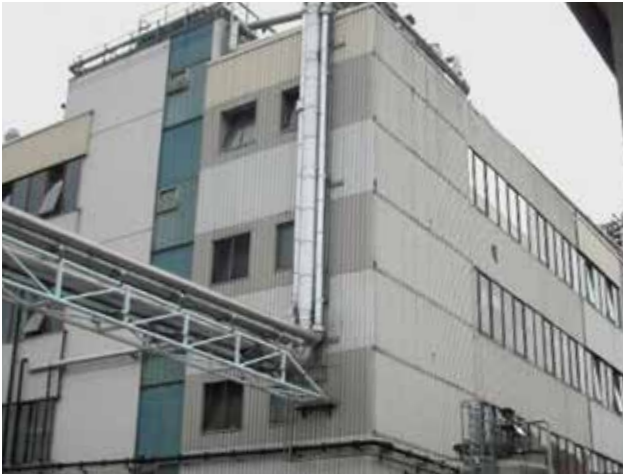
Foto 1: Produktionsgebäude vor der Sanierung
