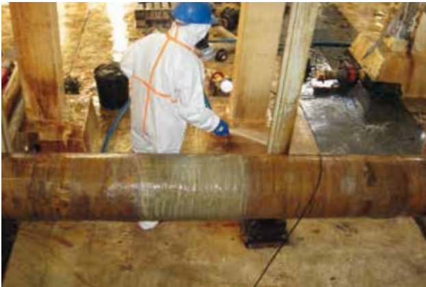
Reinigungsarbeiten im Keller / Südseite
