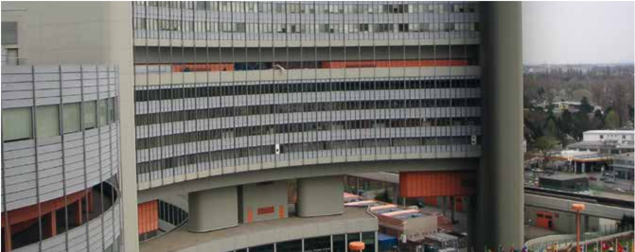
Puffergeschoss zwischen Baustelle und Nutzerbereich
