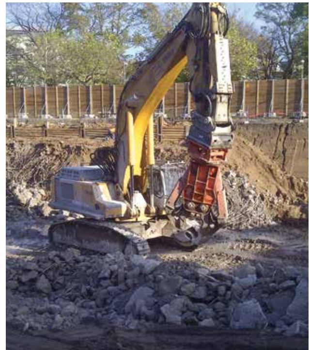
Nach der Sprengung übernimmt die Betonschere den Rest.
