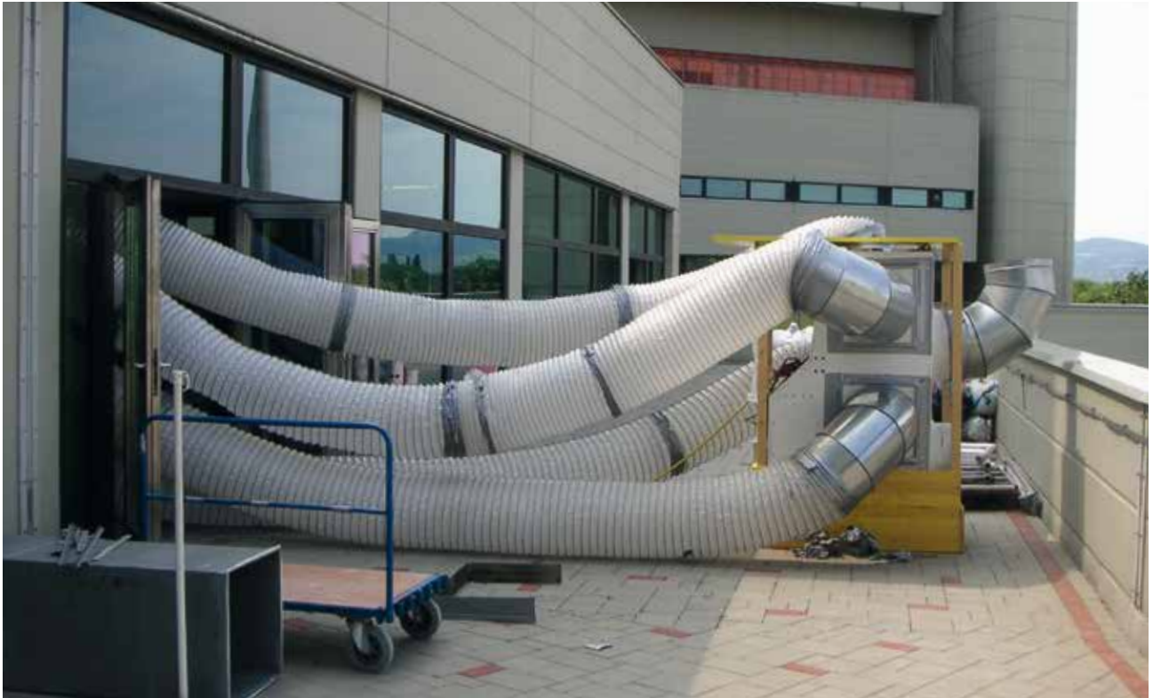
Das Gebäude mit 4000 Angestellten konnte im laufenden Betrieb saniert werden.
