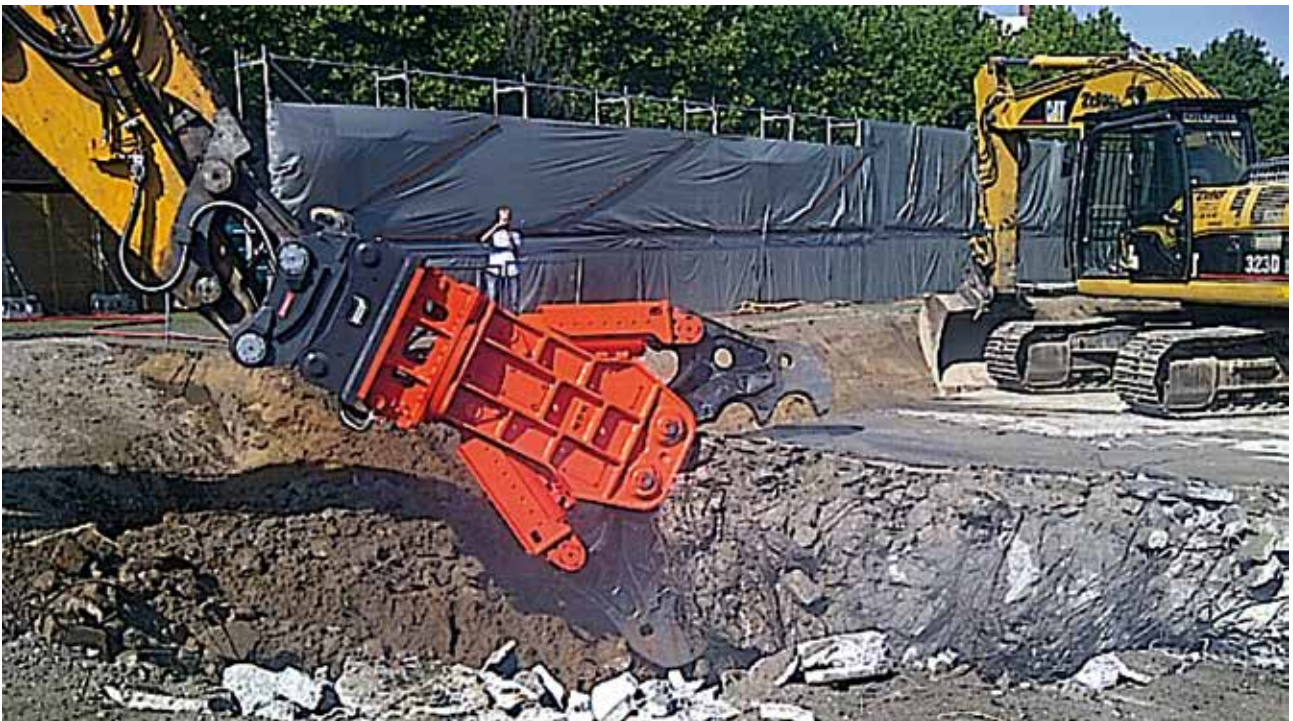
Deutschlands größte Abrisszange, die Betonschere „NPK 90 XCR“, zerlegt den Bunker.
