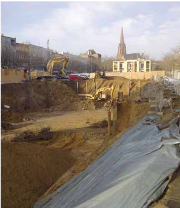
Rückbau der Bunkeranlage
