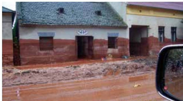
Von Rotschlamm betroffene Häuser
