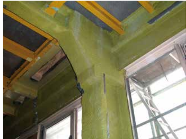
Foto 2: Spritzasbest beschichtet an Stahlträgern und Stütze
